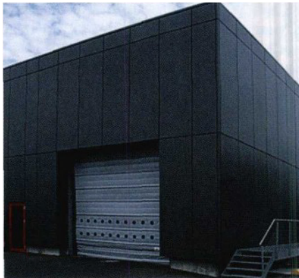
Porte à ouverture rapide et souple pour un emploi dans l'industrie.
