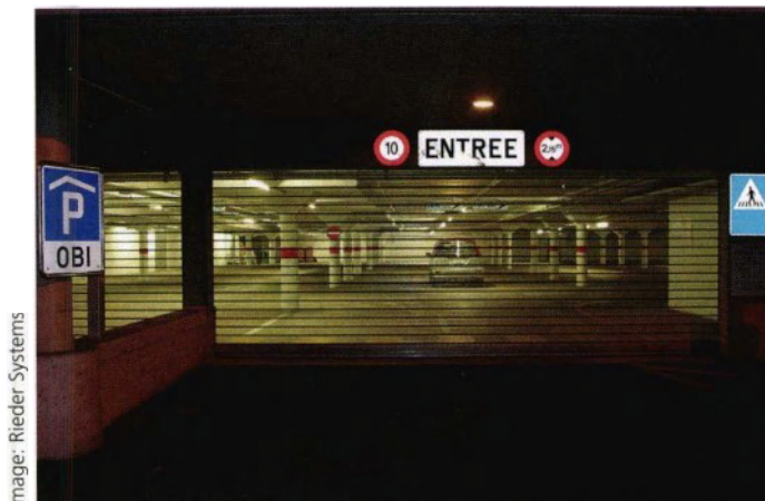
L'une des réalisations de Rieder Systems.
